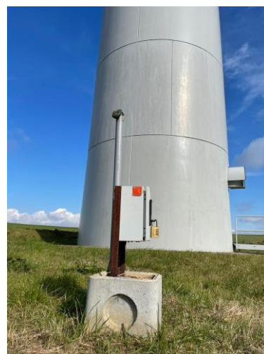
Photo 1. Coffret contenant l'enregistreur de Chauves-souris au sol
